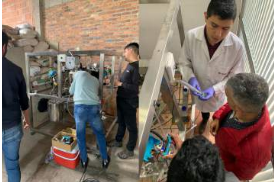
Imagen 20. Monitoreo y mantenimiento sistema eléctrico y electrónico
