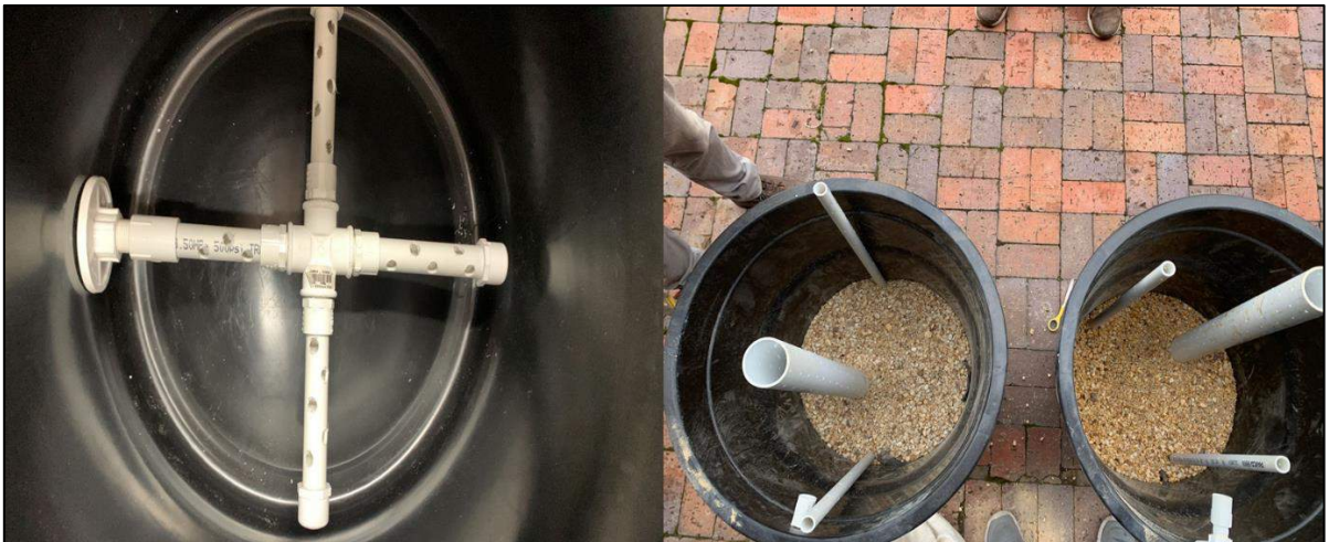
Imagen 16. Construcción planta Bio
