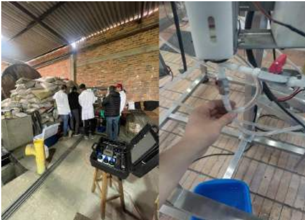
Imagen 20. Monitoreo y mantenimiento sistema mecánico
