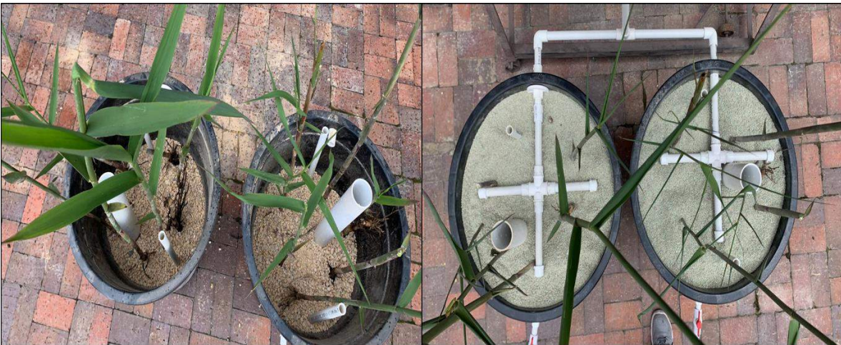
Imagen 17. Construcción planta Bio
